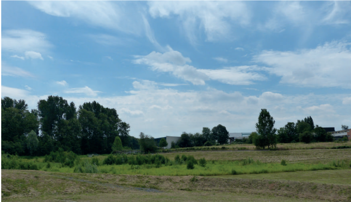
Abb. 32: Regenrückhaltebecken am Oespeler Bach
