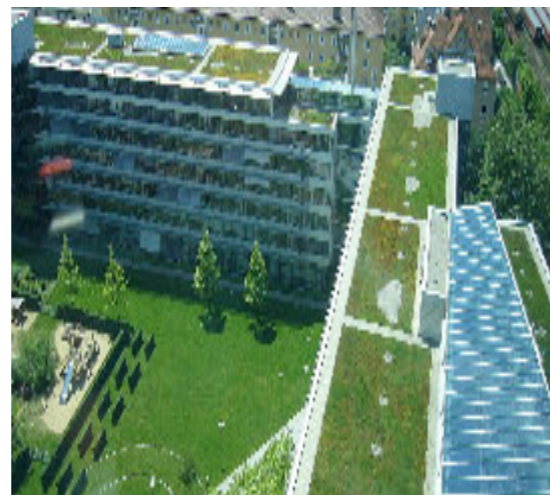
Abbildung 10: Dachbegrünung (Quelle: Wikimedia Commons)
