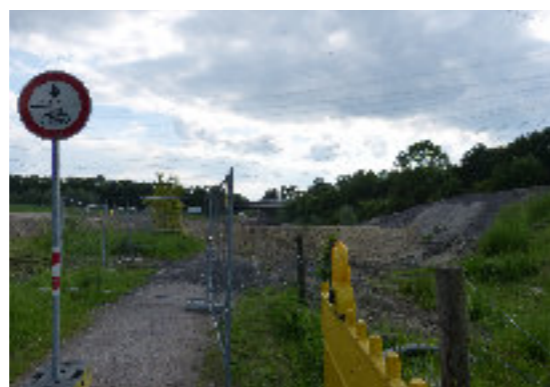
Abbildung 35: Grünfläche am Roßbach (Blick auf die Baustelle) (Quelle: Eigene Aufnahme)
