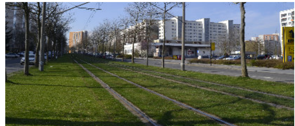
Abbildung 11: Begrünte Stadtbahngleise in Dresden Prohlis (Quelle: Eigene Aufnahme)
