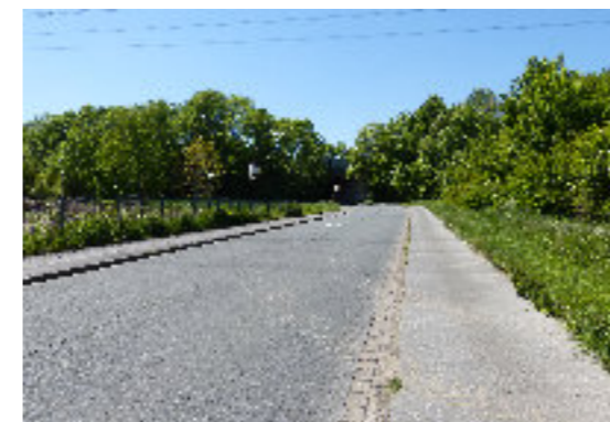
Abbildung 68: Wischlinger Weg (Straßenraum) (Quelle: Eigene Aufnahme)
